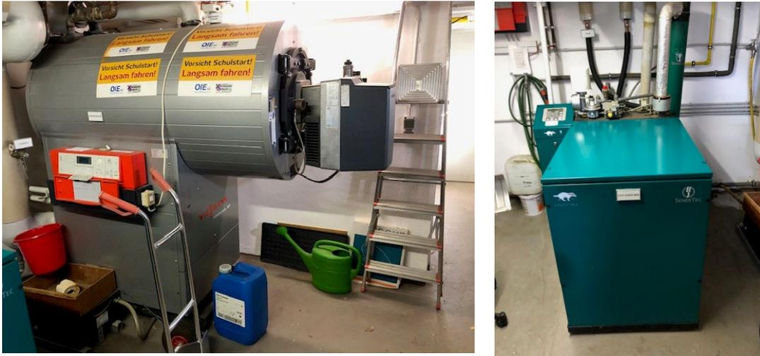
Abbildung 5: NT-Gaskessel und Erdgas-BHKW im Verwaltungsgebäude der VG
