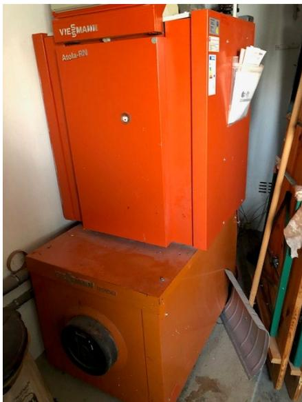
Abbildung 6: Erdgas-Kessel mit WW-Bereitung in der KiTa
